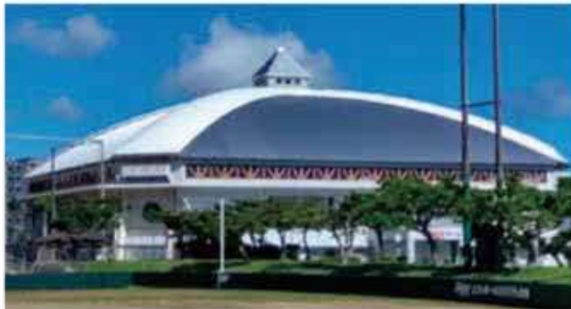
▲北谷町営多目的屋内運動場 (外観) (人工芝・防球ネット取替え・補修)
